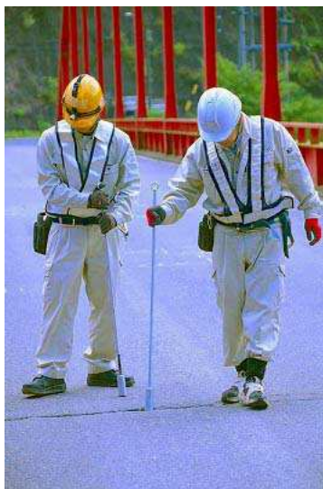
<アイハンマーはコンクリート床版、鋼床版など様々な現場で使用されています>
