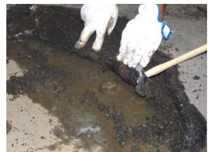
写真3：舗装を撤去した状態
