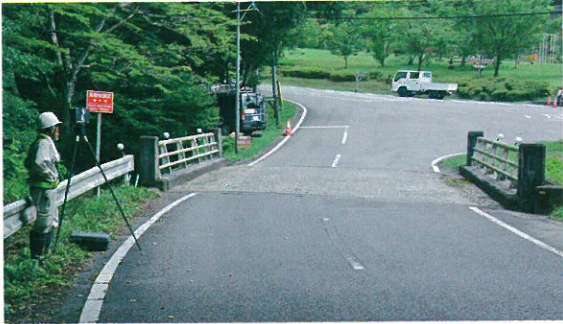
スキャナ(写真左部分)と欄干に取り付けられた基準点
