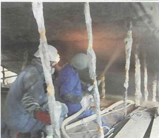
大崎地区橋梁工事・吹き付け中
